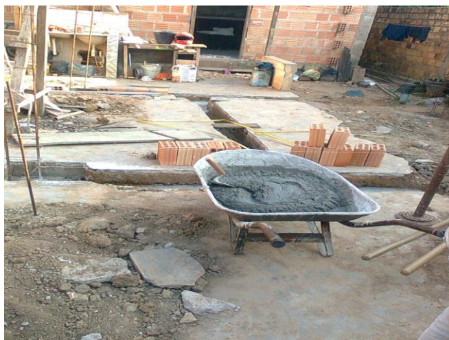
Figura 2 – Preparando um traço de massa Fonte: Dados da pesquisa
